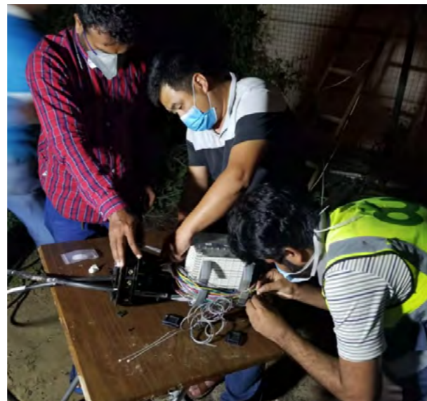
2020 年 3 月 29 日，中国通信服务阿联酋迪拜公司 DU 线路项目部工作人员在阿拉伯联合酋长国迪拜市 Wasan 方舱医院进行光缆布放和熔接工作
