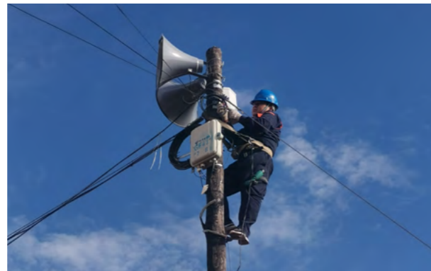
2020 年 7 月 20 日，新疆公司员工在哈密市伊吾县前山乡塔拉布拉克村安装“天翼大喇叭”，5 天完成哈密市伊吾县 28 对大喇叭的安装调测，实现偏远地区的信息覆盖
