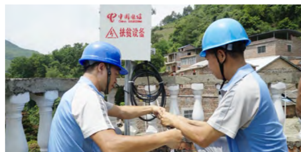
中国电信开展网络建设，让普遍服务走进壮家瑶寨。图为中国电信工作人员为田林县偏远地区建基站拉光缆
