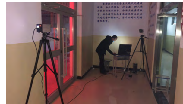
2020 年 3 月 13 日，青海公司为提高学生返校体温检测效率，借助技术优势，实现体温测量多人同步感应，确保师生体温检测工作快速、高效，有效解决了学校防疫人员紧缺、手工测温效率低的问题。图为在海东市化隆回族自治县群科中心小学安装热成像测温设备
