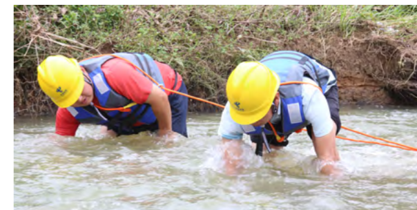
2020 年 7 月 16 日，江西省九江市湖口分局工作人员在都昌马洞桥河附近摸排河底光缆，确保干线安全
